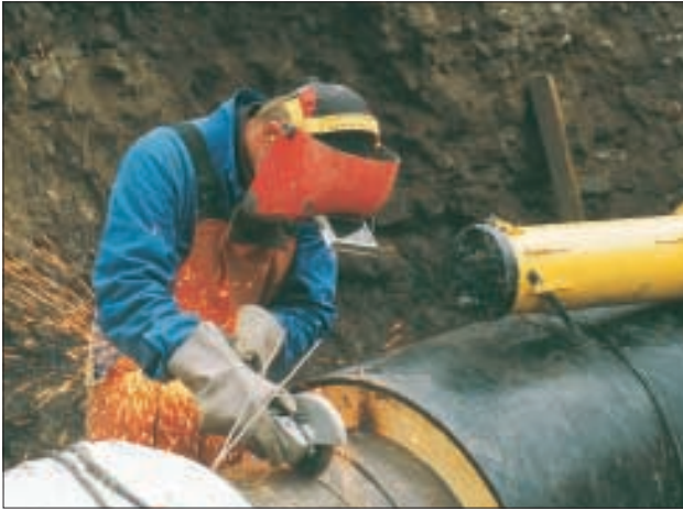
Svetsning av fjärrvärmerör.
